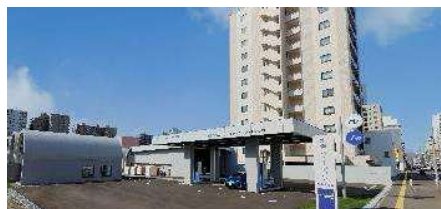
▲水素ステーション
