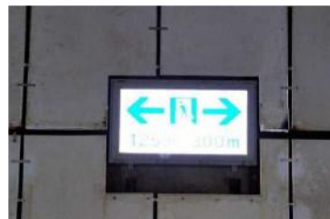
トンネル完成状況
