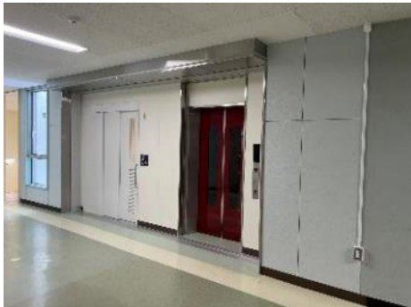
▲ エレベーター
