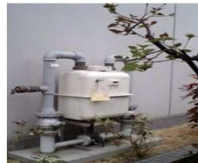
③ガス変換機接続口
