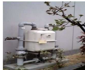
③ガス変換機接続口
