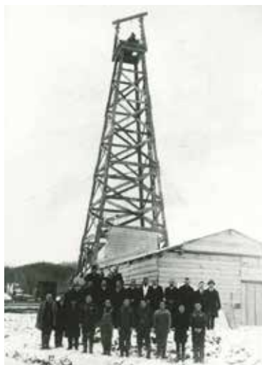
写真-13 油沢の石油試掘現場 (昭和9年)
