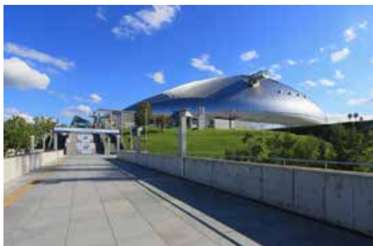
写真-10 札幌ドーム
