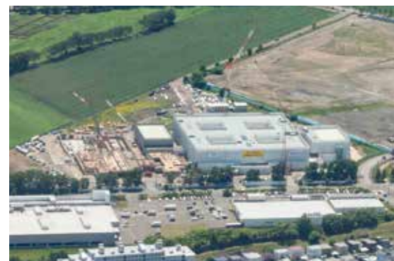
写真-7 建設中の日本医療大学（令和 2 年）
