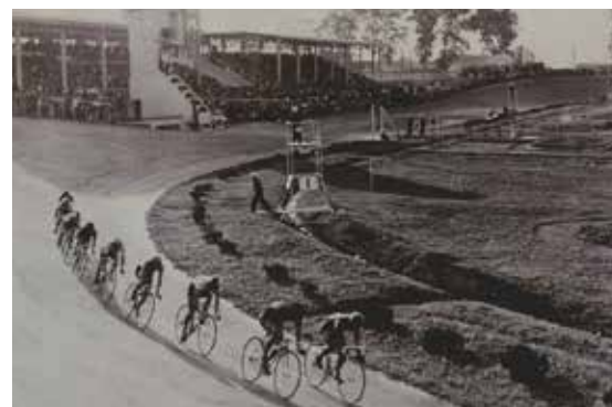
写真-7 道営札幌競輪場
