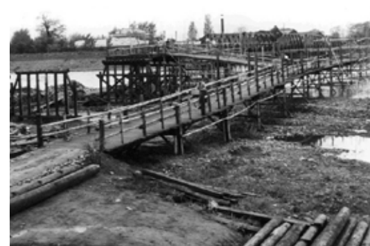
写真-7 建設中の幌平橋（昭和28年）
