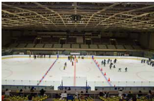
写真-3 月寒体育館(令和4年)
