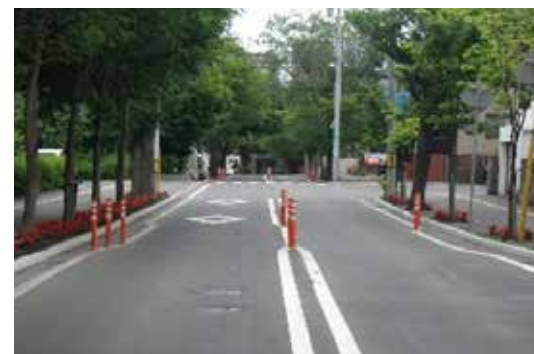
写真-3 狭さく部(区画線とラバーポール)
