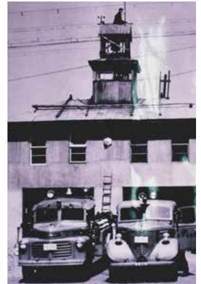
写真-1 豊平町消防本部 (月寒中央通 5 丁目、昭和 30 年)
