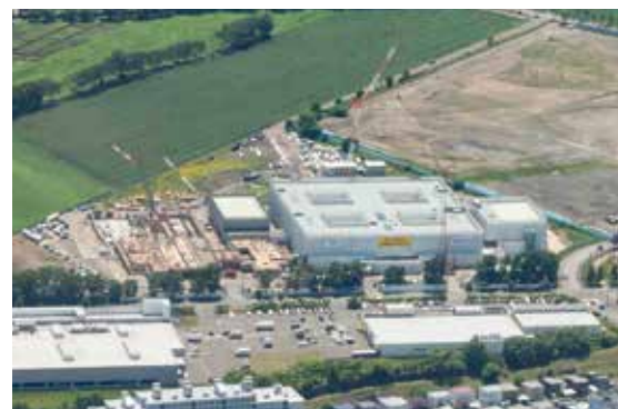
写真-7 建設中の日本医療大学（令和2年）
