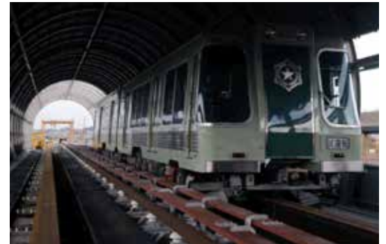
写真-5 南北線のシェルター工事の様子
