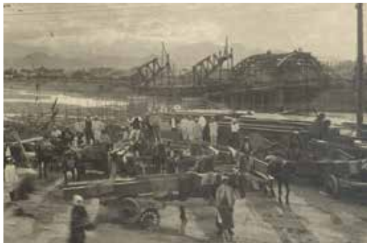
写真-5 豊平橋の工事の様子 (大正12年、手前が豊平側)
