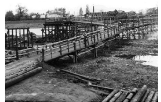
写真-7 建設中の幌平橋（昭和28年）
