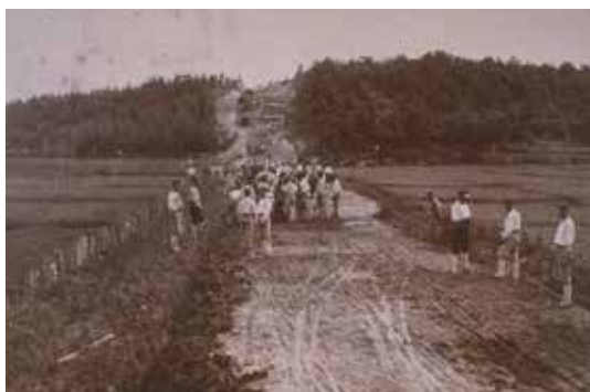
写真-3 アンパン道路の工事(明治44年)
