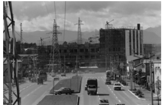
写真-8 建設中の区役所新庁舎（昭和48年）
