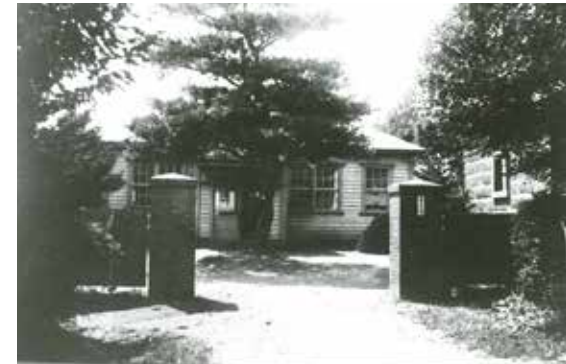
写真-3 大正9年に改築されたもの
