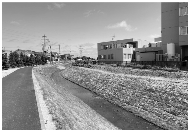
▲河川改修事業（厚別西川）
