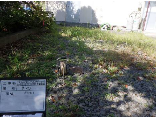
観測孔蓋 近景
