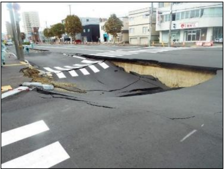
図 2-14 北海道胆振東部地震による被害
