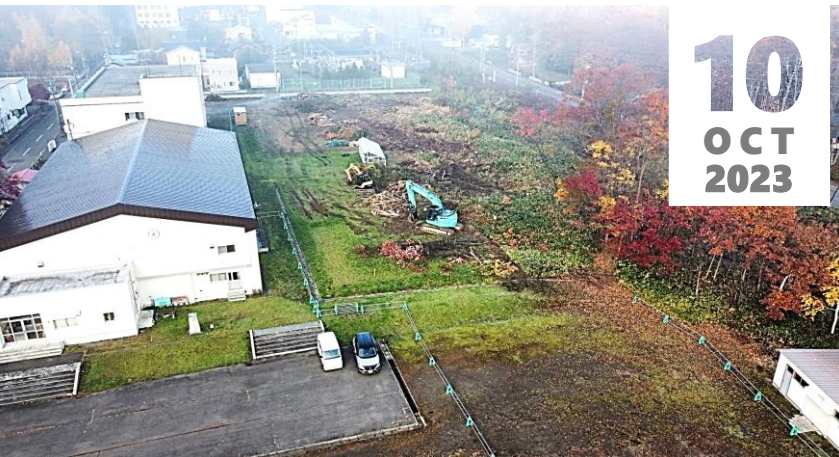
樹木伐採・伐根 先行解体
