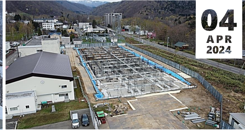
土工事 地業工事
