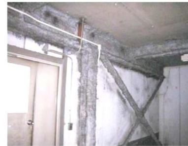
吹付けロックウール (岩綿吹付)
