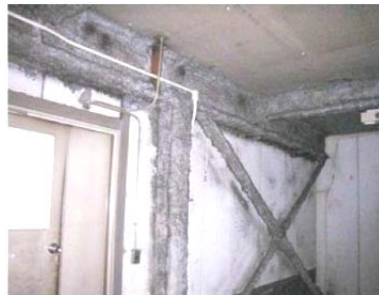
吹付けロックウール (岩綿吹付)
