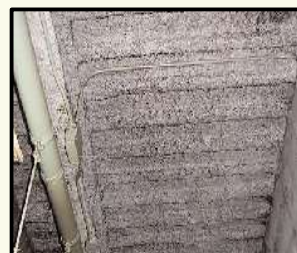
吹付けロックウール
