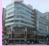
日の出ビル (本館s36・新館s46) まちづくり会社によるコワーキングスペース
