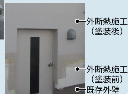
▲既存集合住宅外壁断熱改修の事例
