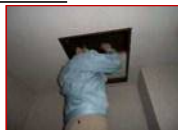
(小屋組・梁) インスペクション現場(例)
