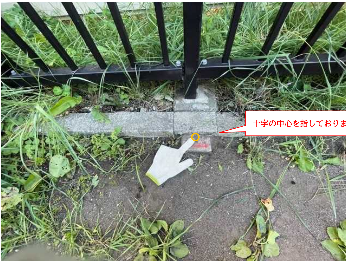
物件区分A（光星団地1号棟）①案内図：写真4－2
