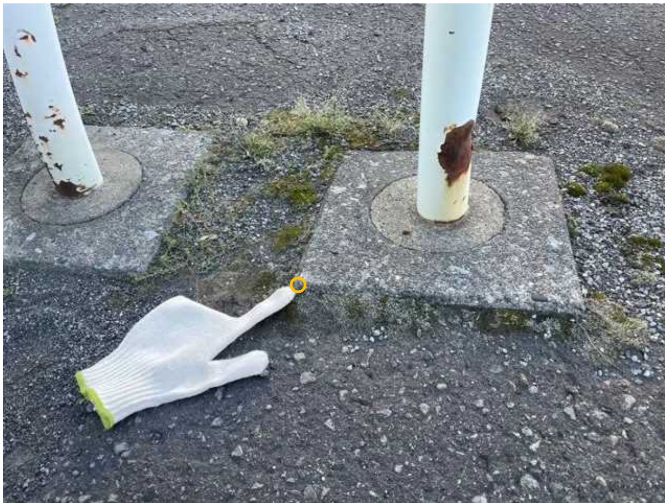
物件区分A（光星団地1号棟）①案内図：写真2－2
