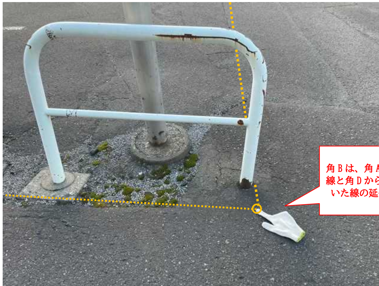
物件区分 A（光星団地 1 号棟）①案内図：写真 3－2
