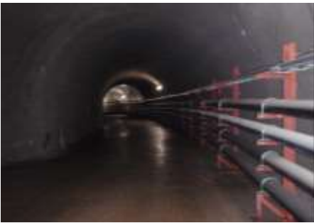
五番坑道 導水設備
