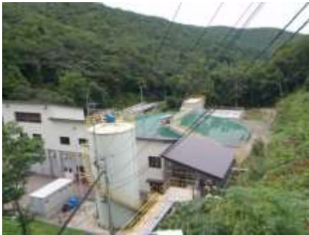
滝の沢処理施設全景
