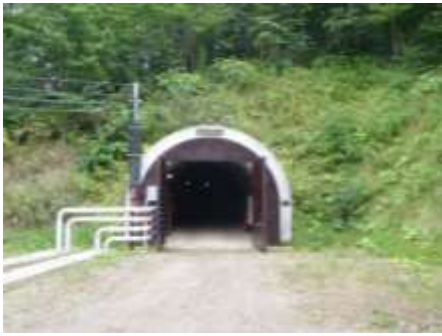
滝の沢斜坑（導水トンネル）
