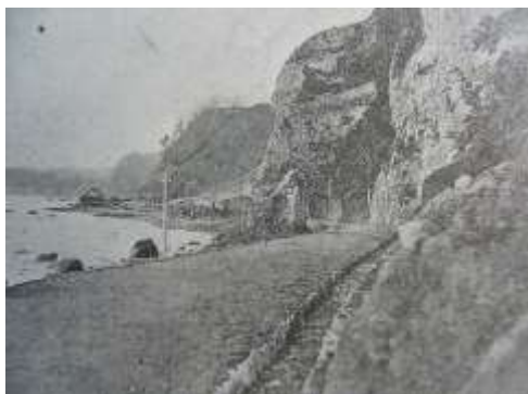
「張碓村隧道(小樽ノ方ヨリ見タル景)」 —1879(明治12)年撮影/北大附属図書館 所蔵写真—
