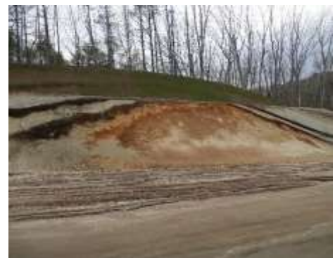
新しい道路の建設現場
