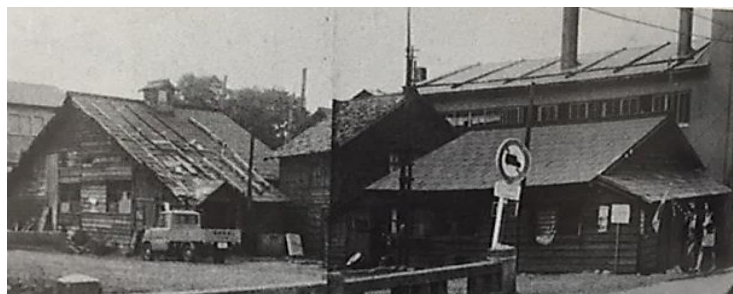
明治期築の精米所の全景／1965（昭和40）年撮影＝手前に軽川
