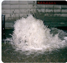
▲地面から噴水のように漏れている様子
