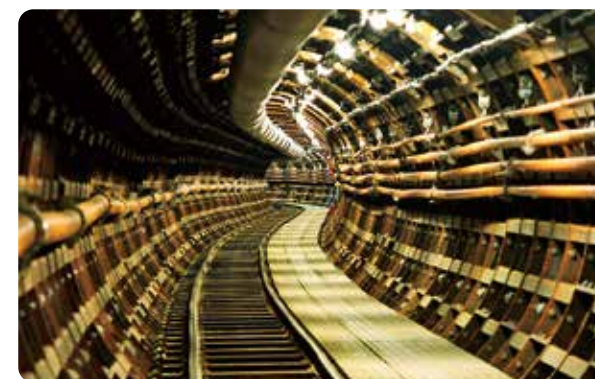
白川第3送水管布設工事(管を布設する際のトンネル内部) 【平成15(2003)~令和元(2019)年】
