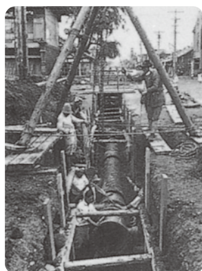
創設期の管敷設工事
