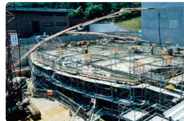
藻岩浄水場改修工事【平成9(1997)~15(2003)年】
