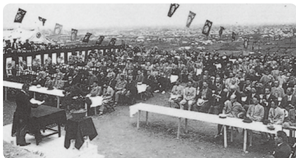
創設水道起工式【昭和9(1934)年】
