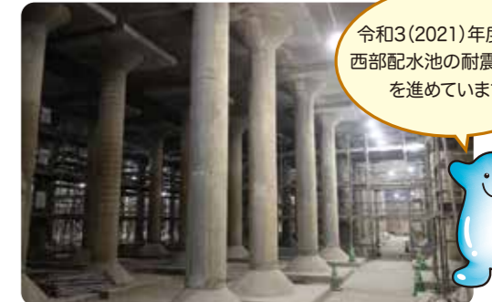
西部配水池耐震改修工事
