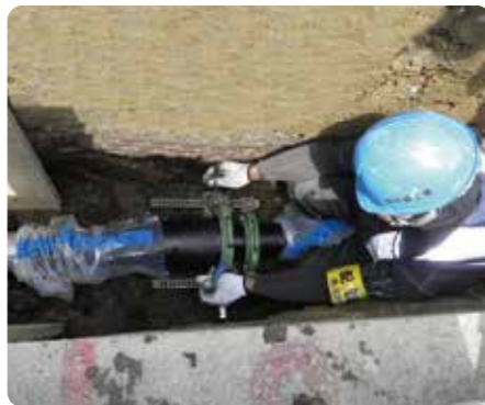
配水管の接合
