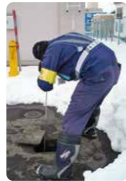
水道メーターの音聴調査
