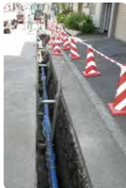
配水管の布設状況
