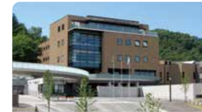
藻岩浄水場 中央区伏見4丁目6番
