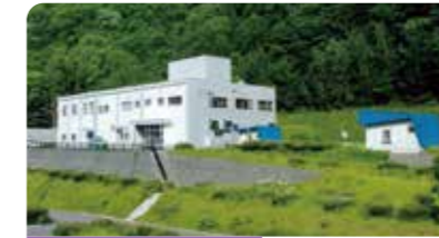
定山溪浄水場 南区定山溪温泉6区
