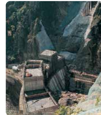
豊平峡ダム工事のようす
