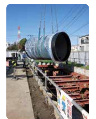
緊急貯水槽設置のようす
