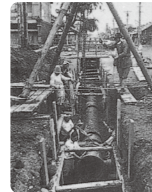
水道管工事のようす
