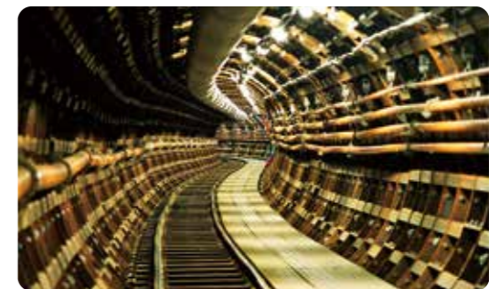
白川第3送水管の工事のようす
