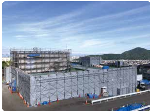
西野浄水場の改修工事の様子 【令和元(2019)～5(2023)年】
