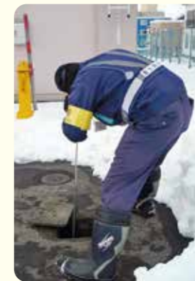
水道メーターの調査のようす
