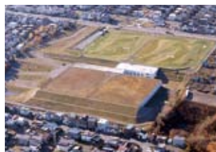
▲配水池の様子
