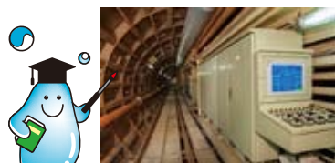
▲新しい送水管を入れるためのトンネル内の様子。
