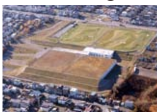
▲配水池の様子
