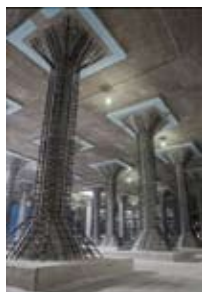
▲耐震化工事中の配水池内の様子
