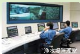
浄水場管理室
