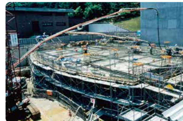
藻岩浄水場改修工事【平成9(1997)～15(2003)年】
