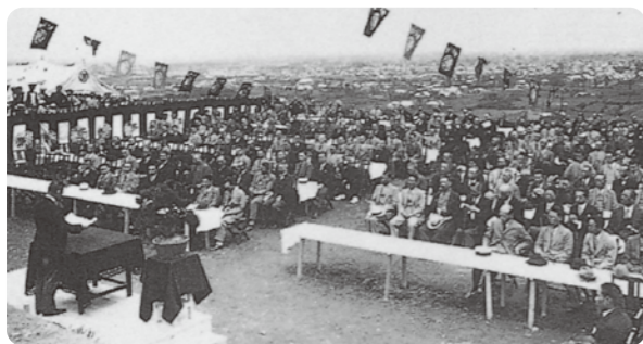
創設水道起工式【昭和9(1934)年】
