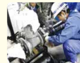
配水管接合実習
