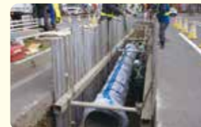
配水管の布設替え
