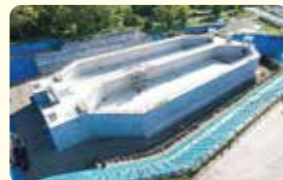
白川新沈砂池の建設
