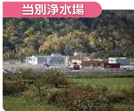
当別浄水場 浄水処理方式は、凝集沈でん+粒状活性炭+急速ろ過を採用し、平成24(2012)年に完成しました。
