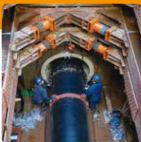
配水本管の耐震化工事
