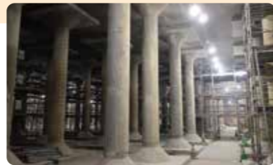
配水池耐震化の状況写真
