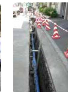
配水管の布設状況
