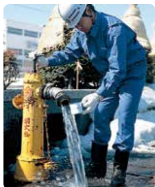
濁水処理作業
