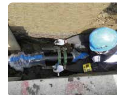
配水管の接合
