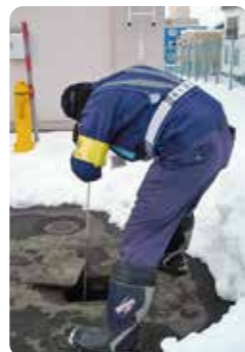
水道メーターの音聴調査
