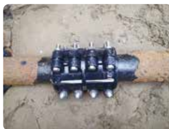
漏水修理完了
