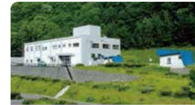
定山溪浄水場 南区定山溪温泉6区
