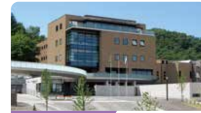
藻岩浄水場 中央区伏見4丁目6番
