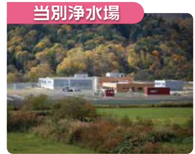
当別浄水場 浄水処理方式は、凝集沈でん+粒状活性炭+急速ろ過を採用し、平成24(2012)年に完成しました。
