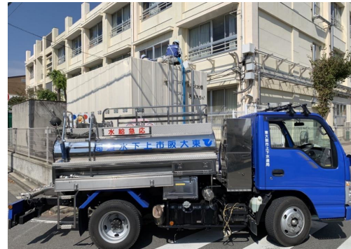
加圧して受水槽に水を送るようす
