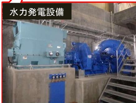
豊平川バイパスの水力発電設備(発電出力770kW)
