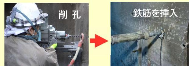
コンクリートの内部に鉄筋が配置されていない位置に削孔して、補強鉄筋を挿入する
