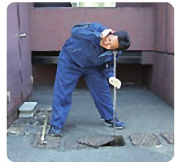
水道メーターの音聴調査
