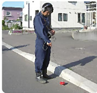
漏水探知器による調査
