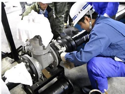
配水管接合実習
