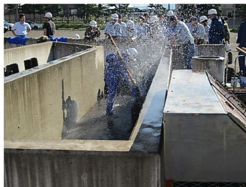
漏水修理実習
