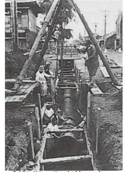
創設期の配水管工事 (主に人の手や馬の力による)
