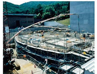
藻岩浄水場改修工事(平成9~15年)
