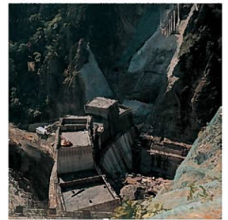
豊平峡ダムの建設
