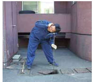
水道メーターの音聴調査
