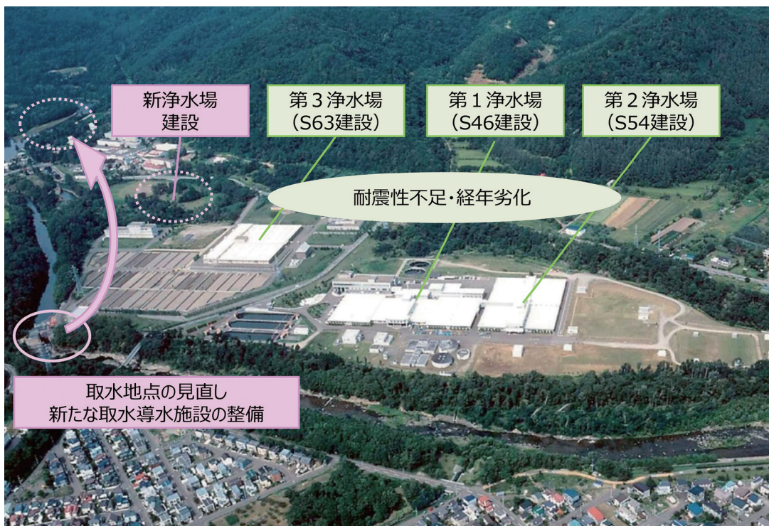
【図表28】白川浄水場の全景
