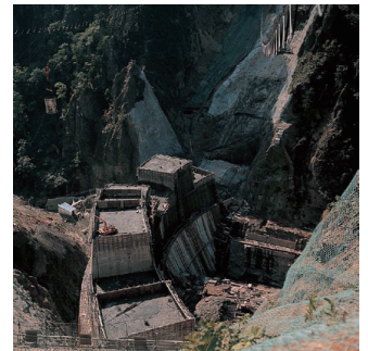
豊平峡ダムの建設
